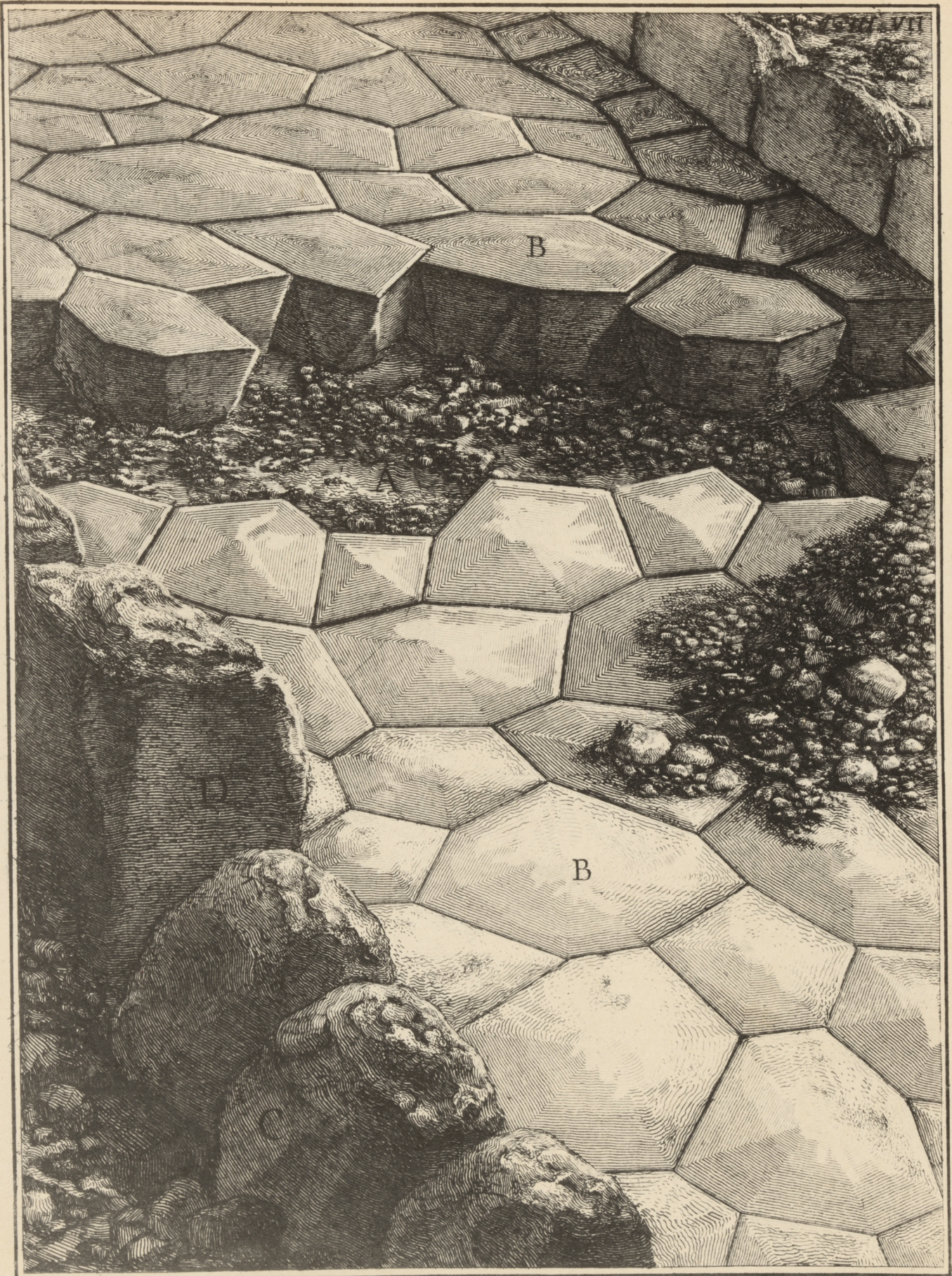
Veduta dell'antica Via Appia, che passa sotto le mura già descritte nelle passate tavole dell'Ustrino, oggi ricoperta nelle rovine del medesimo. A. Letto del terreno ben foderato, e battuto con pali, prima di stendere la grossa riempitura alta palmo uno a simiglianza di lastro come posto di calce pozzolana, e scaglie di felci, sopra di esso piantati a forza i felci B. tagliati nel rovescio a punta di diamante. C. Altri felci posti a guisa di Cunei, i quali stringono e tagliandamente rinserrano i felci sudetti, che lastricano la Via già detta, fra quali ogni 30 palmi ce n'è uno D. più eminente e superiore degli altri di tal fatta, quale dovea servire forse a quelli, che montavano, e smontavano da cavallo, e di riposo a Stanzianti. Questo e gli altri inferiori sono piantati sopra un grosso muro di riempitura di simili scaglie di felci, non più grandi delle mentovate di sopra.
