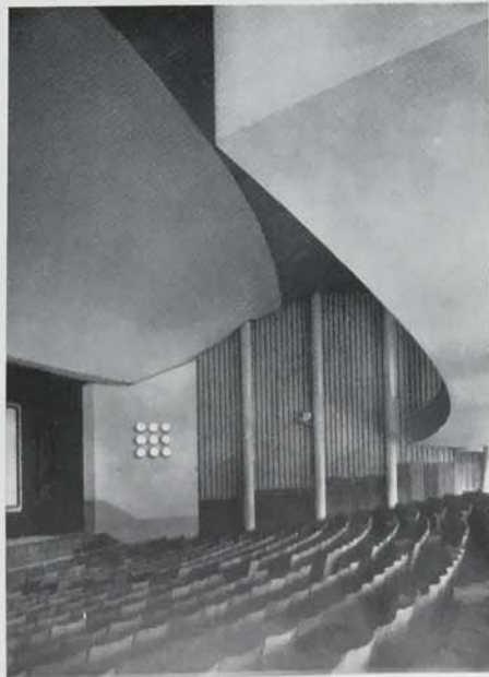
Sopra, l'ingresso principale del cinema e la rampa alla galleria. A fianco, i posti di platea e la parte aggettante della balconata. Particolare dell'ingresso.
