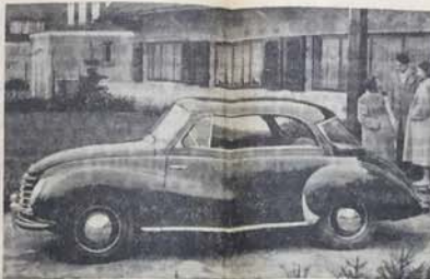
DKW-Sonderklasse mit Dreizylinder-Zweitaktmotor
