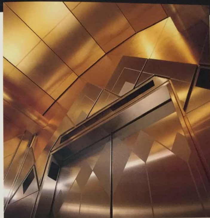
A cathedral-shaped bronze ceiling, etched stainless steel doors combined with wood panels in the interior of an elevator cab. Plafond cathédrale en bronze, portes en acier inoxydable gravé, associés à des panneaux de bois dans une cabine d'ascenseur.
