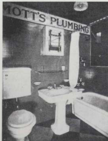
83 Ausstellung von Sanitär- anlagen der Firma J. L. Mott, aus The Plumbers' Trade Journal , 1. August 1915, S. 172
